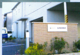
移転した北京都営業所外観
