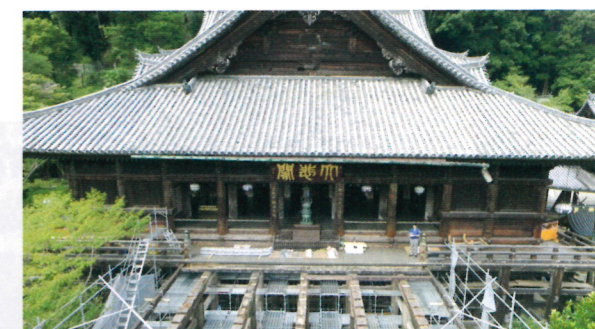
長谷寺本堂(国宝)外舞台の解体修理。365年間舞台を支えてきた柱の一部を取り替えました。
