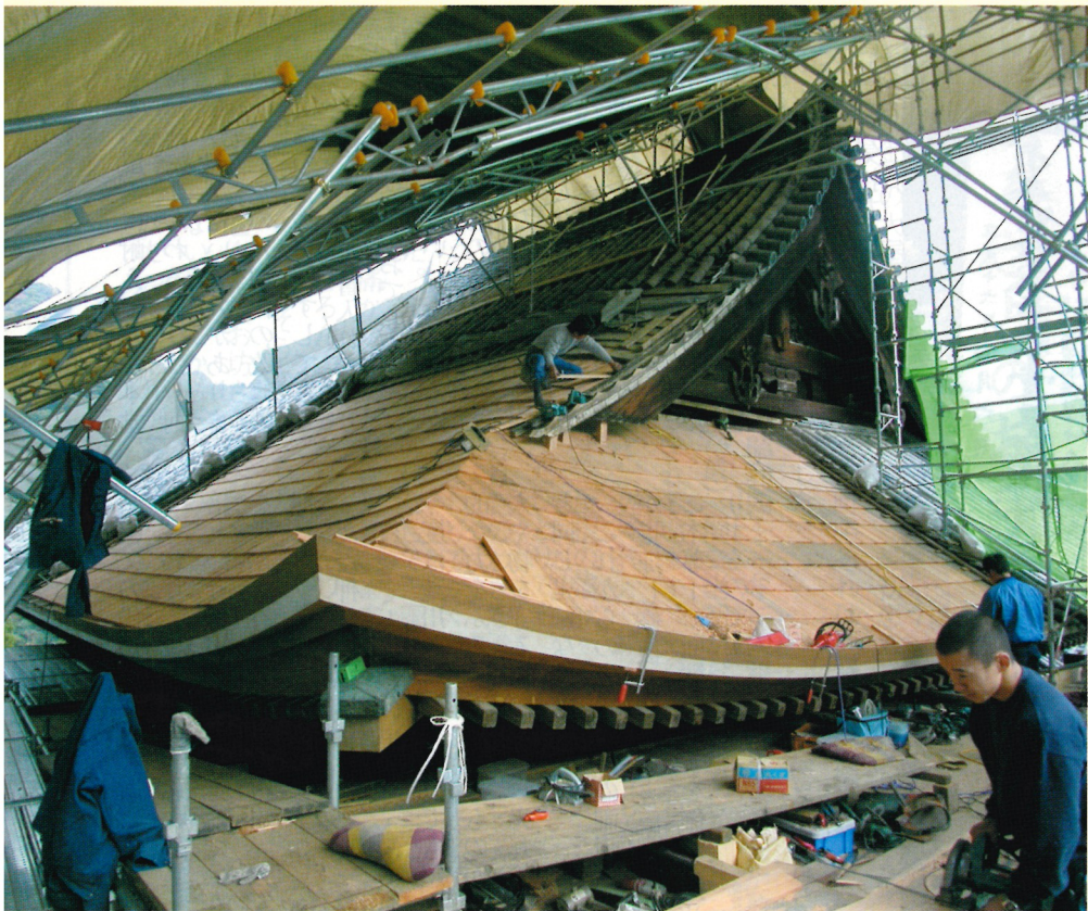
素屋根の下での作業
