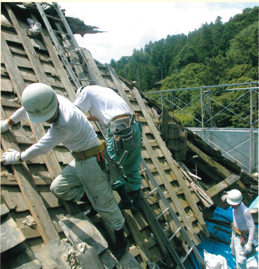
急勾配の身舎の屋根瓦降ろし
