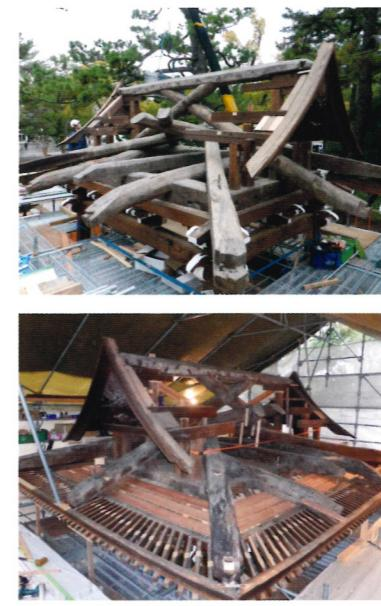
密に行い、破損部分については何故そうなったかを原因究明して行きます。そして修理方針をもう一度検討し、補足する部材の数量、工法を決定致します。
