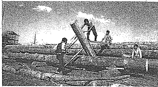
自作のノコギリで丸太を加えるモンゴルの大工たち
