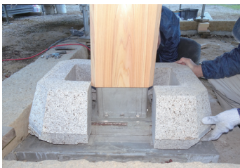
▲柱の根元が地面に触れない工法
